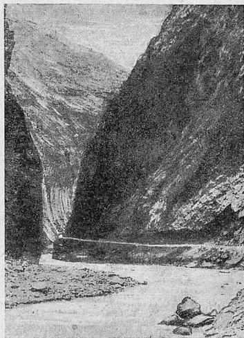
Уфитинская тропа — полутоннель (Дагестан)
